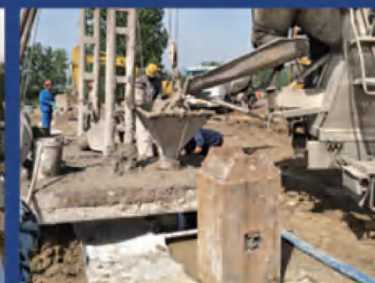
④ 浇筑低渗透墙体材料
